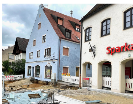
Aktuelle Baustelle vor beiden Eingangsbereichen
