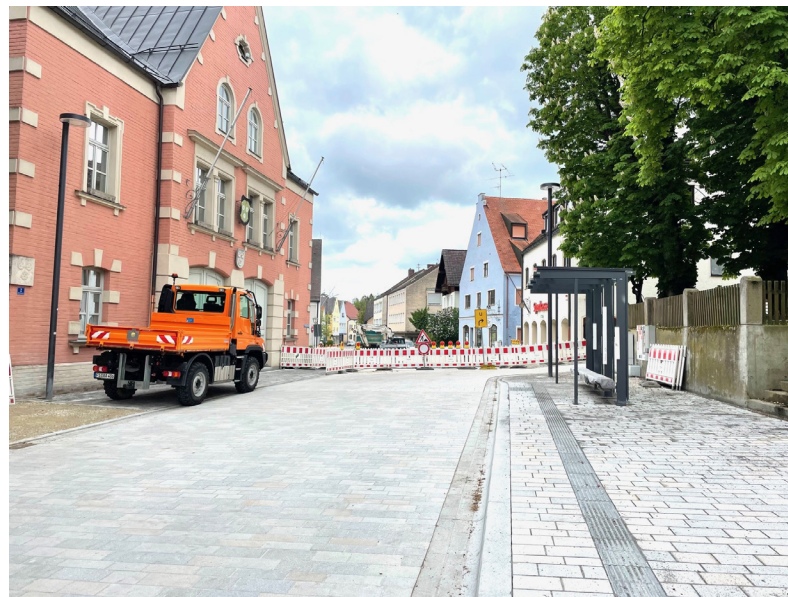
Bushalt auf der Unteren Hauptstraße nach dem Umbau
