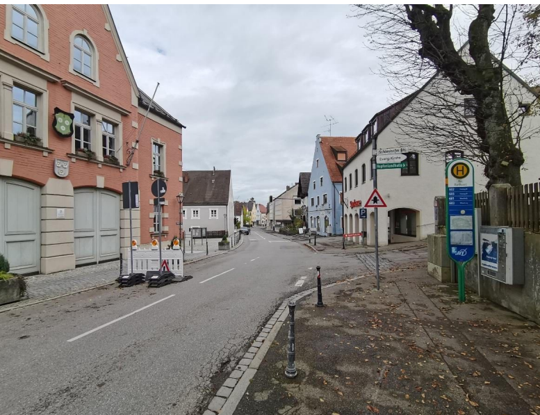
Bushalt vor dem Umbau
