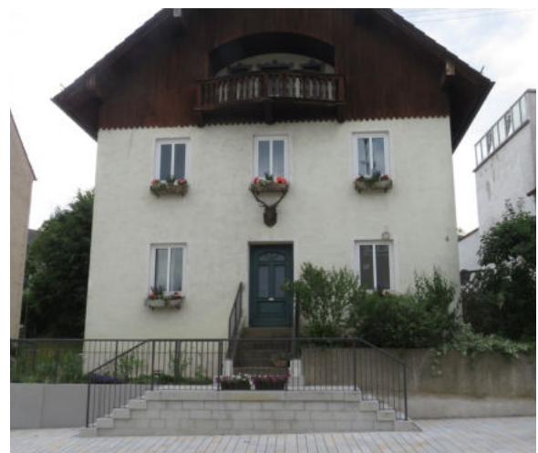
Die Treppenanlage an der Oberen Hauptstraße 6 wurde komplett erneuert und ansprechend gestaltet.
